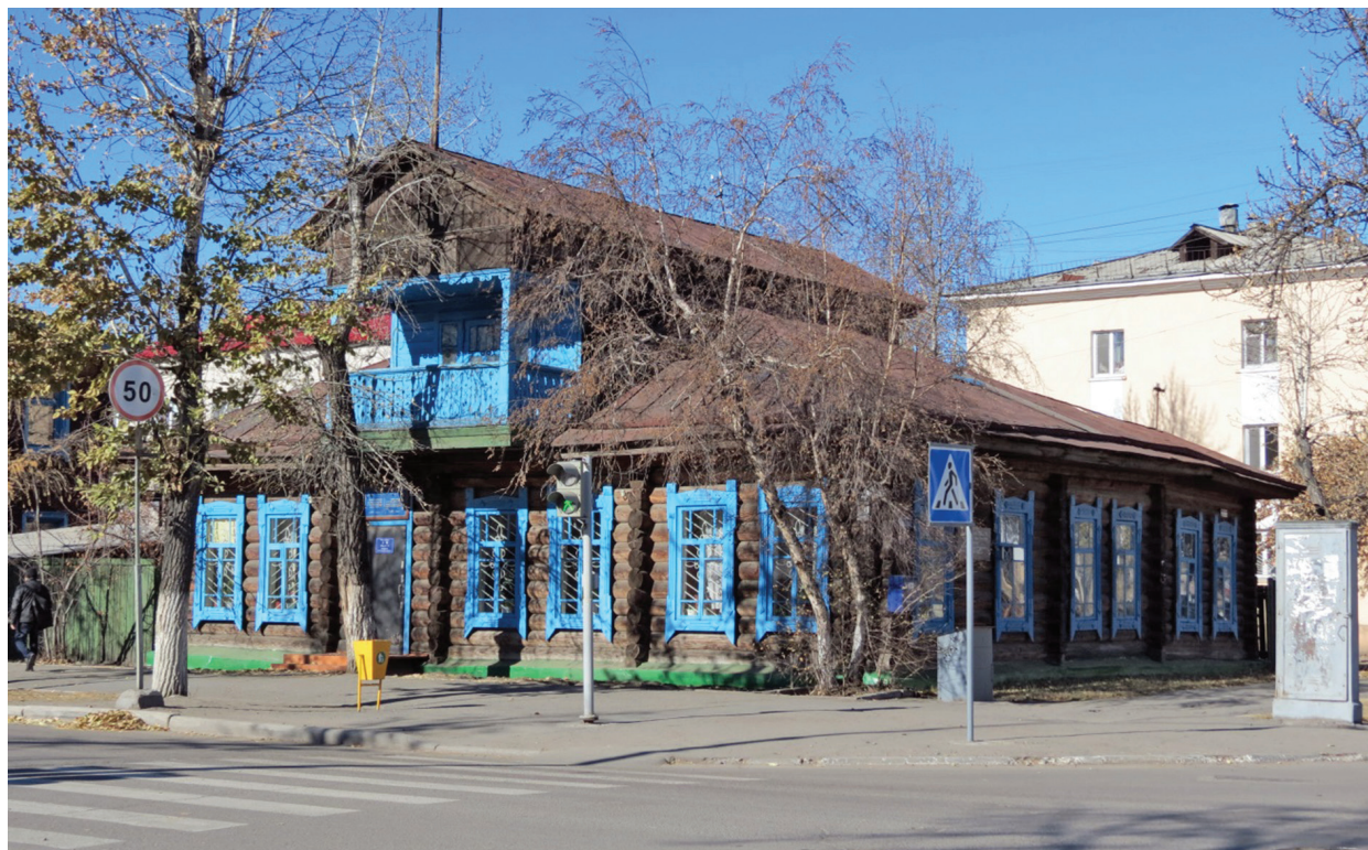
Рис. 1. Здание по улице Ленина 20 Кызыла
